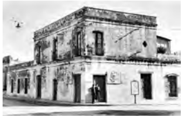
Casa de Domingo Crespo, antes de Francisco Alzogaray, fotografía Danilo Birri.
