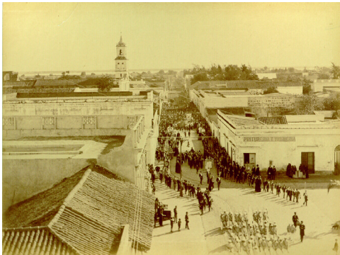
FOTO 1: Vista tomada desde la azotea del Cabildo hacia el oeste, haciendo eje en la calle 3 de febrero.
